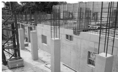
Рис. 1. Здание, построенное методом монолитной заливки
